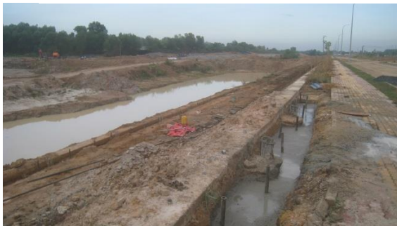
Hình 20. Hệ thống cọc khoan nhồi và ống D49 phục vụ xi măng
