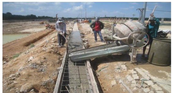
Hình 22. Đổ bê tông đầm đỉnh đường
