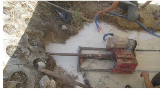
Hình 14. Khoan ngang qua đường
