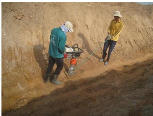
Hình 13. Đầm nén đất tạo độ chặt trên rãnh cát
