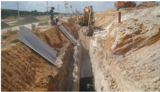
Hình 10. Thi công tạo rãnh cát
