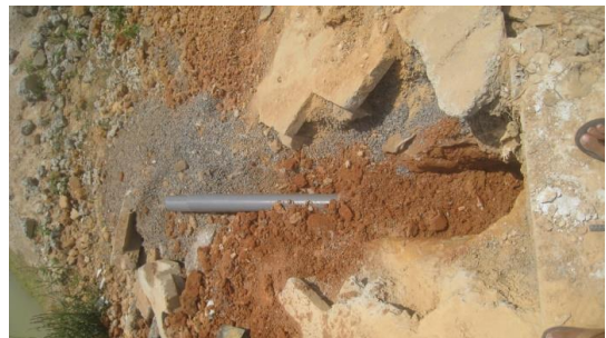
Hình 15. Ống D90 qua đường
