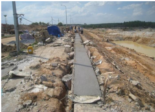
Hình 24. Bê tông đầm dìm đường
