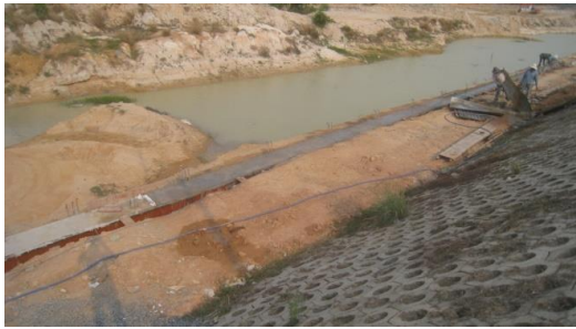
Hình 23. Bê tông đầm dìm bờ kè
