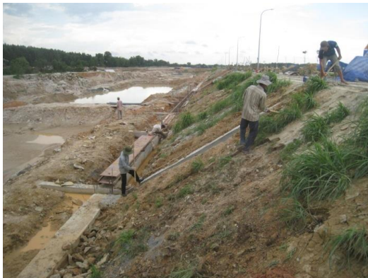
Hình 25. Hoàn thiện bề mặt taluy
