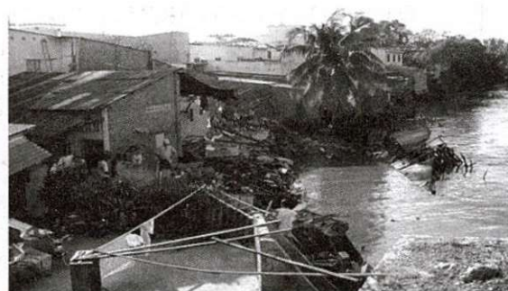
N o 6: Dãy nhà ở chân cầu Kinh bị sụp xuống sông
