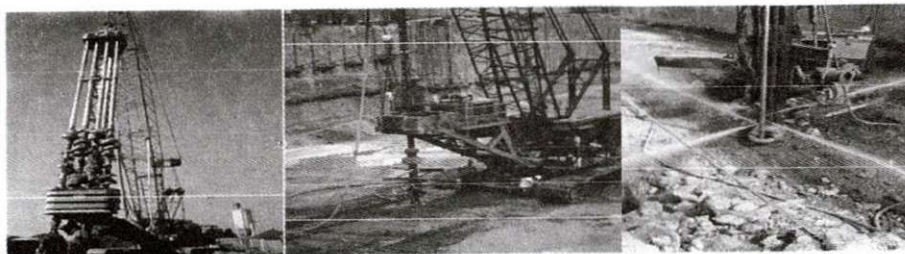
Hình 1. Phương pháp trộn ướt dưới sâu
