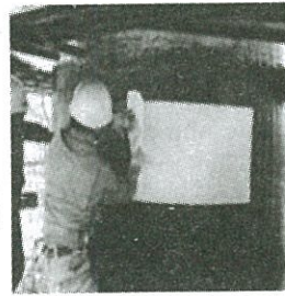
Gia cố ống khói
