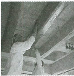
Sửa chữa dầm bằng cách bọc vải FRP
