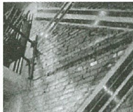
Gia cố tường gạch
