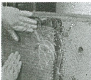
Lắp đặt neo sợi thủy tinh
