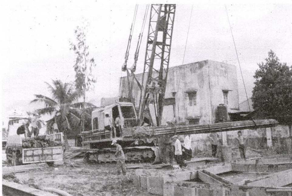
Hình 2: Những bó thép được cần cẩu đang vớt lên (Ảnh do Xí nghiệp khảo sát Địa Chất Công ty khảo sát thiết kế tổng hợp cung cấp, Tháng 3/2000).
