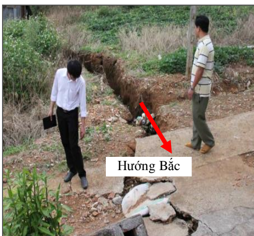
Hình 6. Vết nứt sụp trước căn nhà số 135/33/15, rộng 30cm, sụp sâu 50cm
