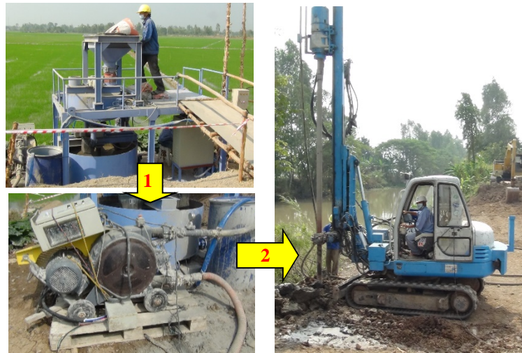
Hình 2. Quy trình thi công cọc đất xi măng
