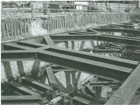
Hình 4. Hệ tường chắn và thanh chống
