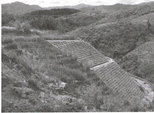
Hình 2a: Khối trượt được gia cố bằng gạch lỗ trên đỉnh, bảo vệ trụ điện
