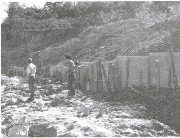
Hình 5: Khối trượt đang được gia cố bằng cọc khoan nhồi và tường trọng lực
