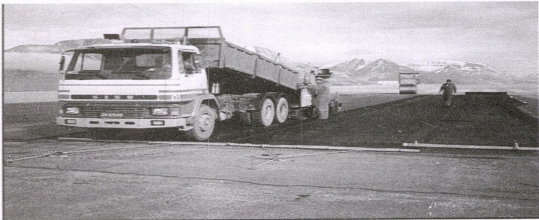
Hình 6 : Trải lớp vật liệu Hatelit để gia cường tại vị trí nối tiếp giữa đường lăn vào đường bay
